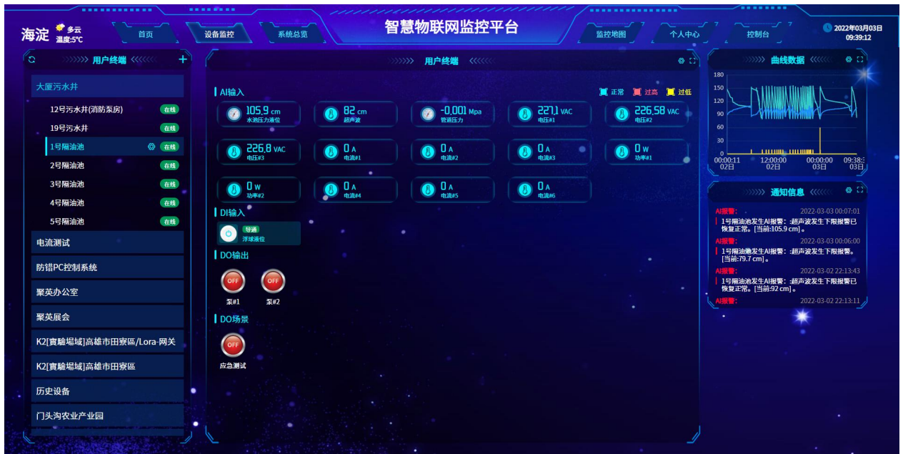
电脑端监控平台
